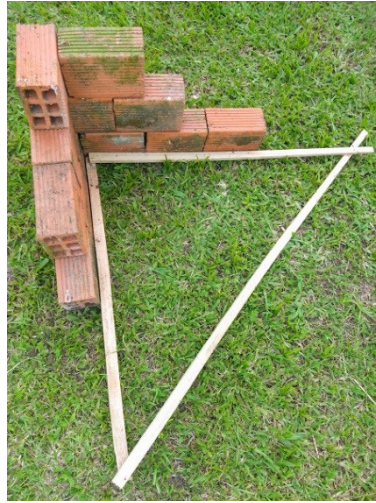
Figura 2: Parede feita com tijolos alinhados com o esquadro grande
